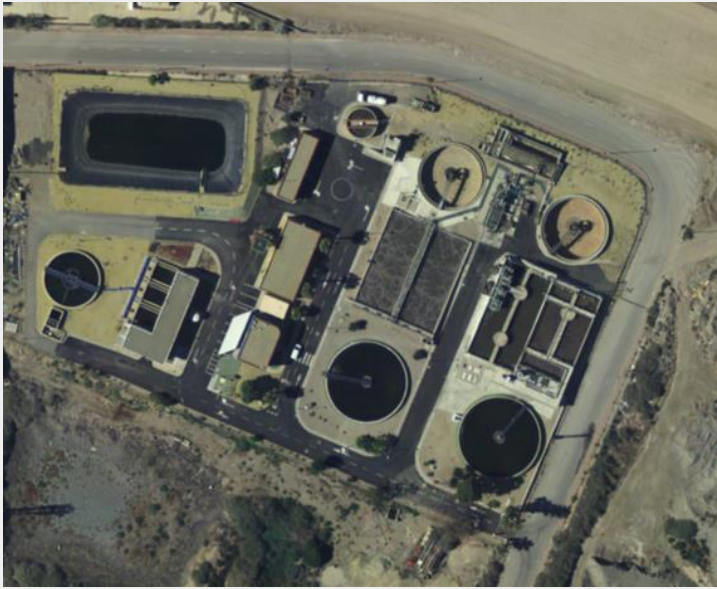
1ª ampliación EDAR Águilas
